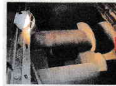
焼却炉のコンベヤ内部 (通常時)
